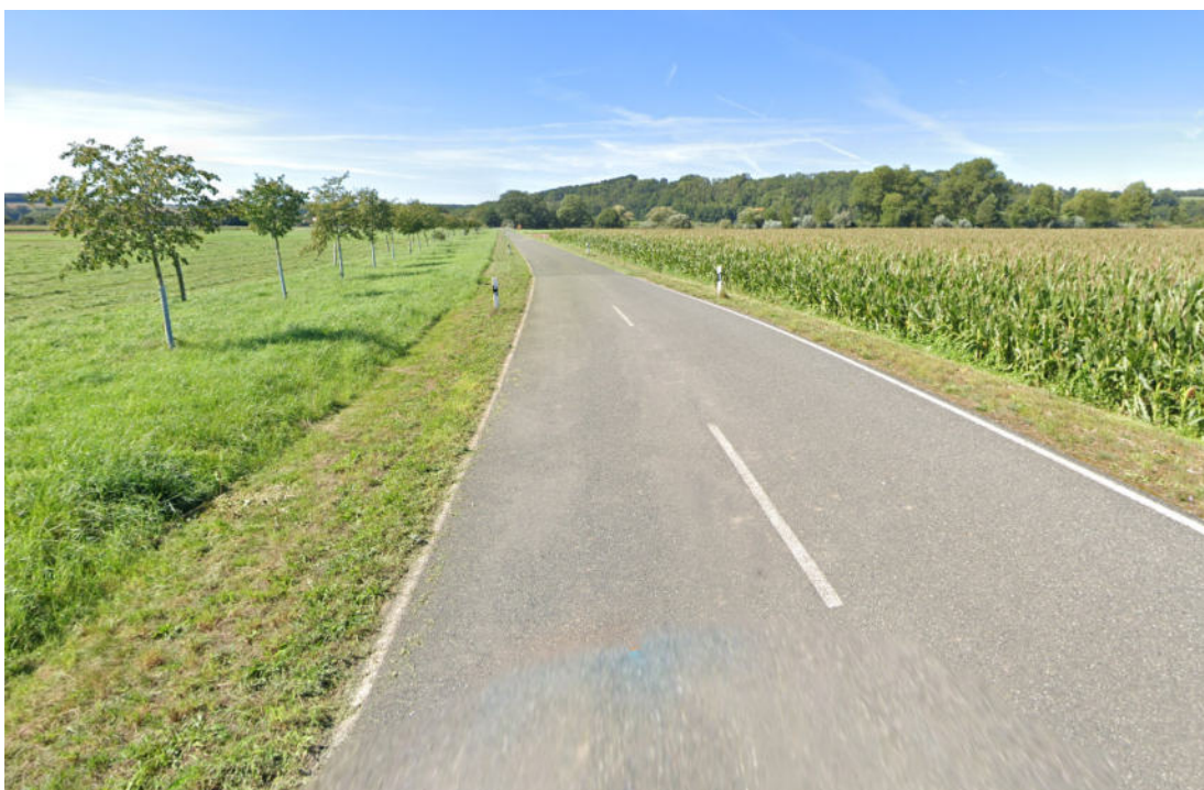
Abb. 26: Darstellung des zu sichernden Böschungsabschnittes entlang des südlichen Straßenrandes der GVS Niederau - Unterneuses, Blick aus Richtung Osten nach Westen, Stand: 09/2023, Quelle: Google Earth)
