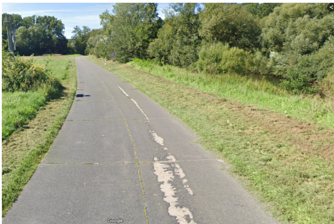
Abb. 27: Blick entlang der GVS von Osten in Richtung Norden; am rechten Bildrand erkennbar ist der bestehende Wall (s. leicht bräunliche Färbung) entlang der Straße; die Flächen werden regelmäßig gepflegt (Quelle: Google Earth)
