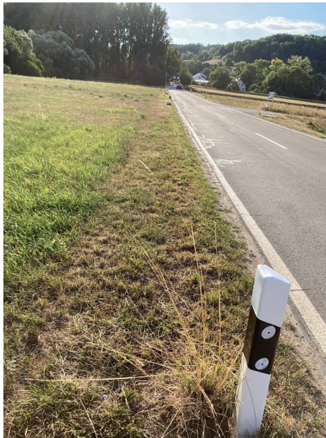
Abb. 8: Darstellung des zu sichernden Böschungsabschnittes entlang des südlichen Straßenrandes der Kr LIF 20 (Blick aus Richtung Osten nach Westen, Stand: 08/2022, Quelle H & P).
