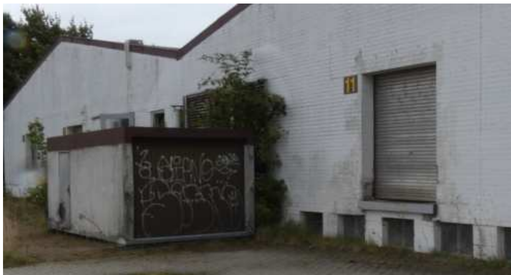
Abb. 10: Fertigteilgarage vor nordwestlicher Hallenschmalseite (Quelle: H & P)
