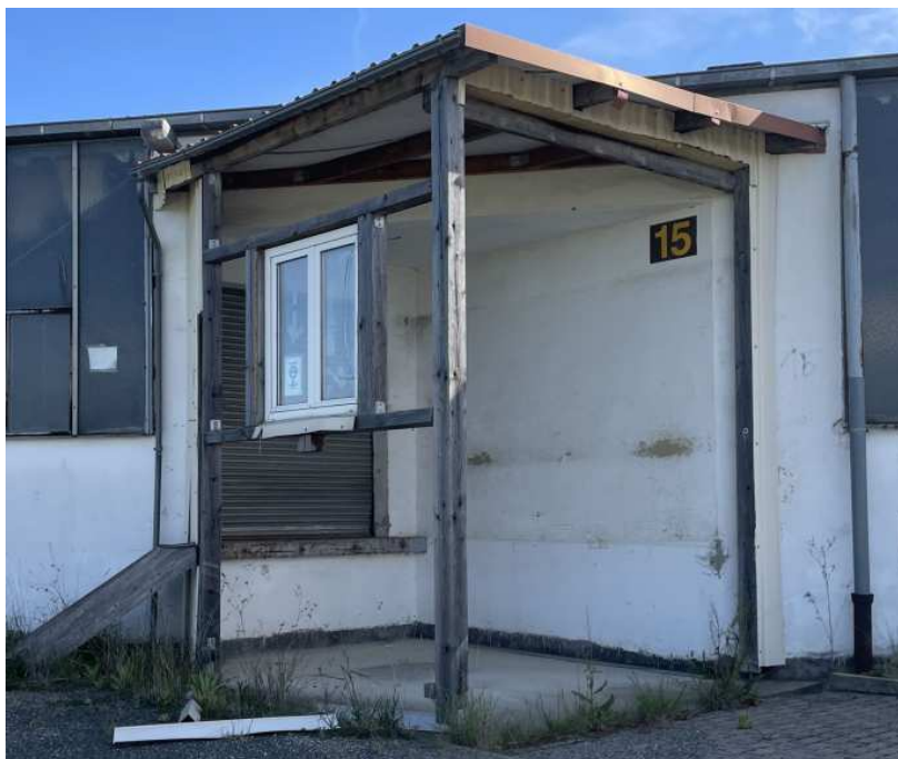
Abb. 18: Offener Anbau an der südlichen Hallenlängsfassade (Quelle: H & P)
