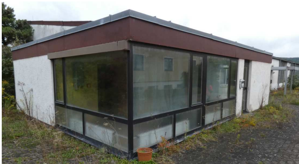
Abb. 12: Anbau Bürotrakt mit potenziell geeigneten Spaltenquartieren (Quelle: H & P)
