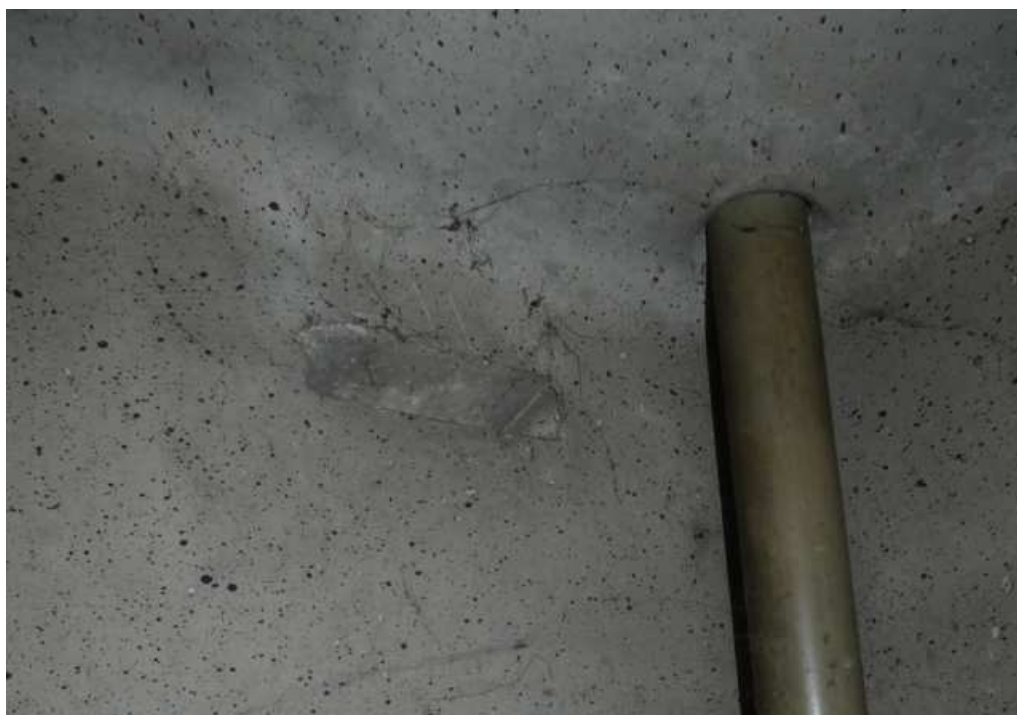
Abb. 11: Obere rechte Ecke Fertigteilgarage mit Lüftungsschlitz (Quelle: H & P)
