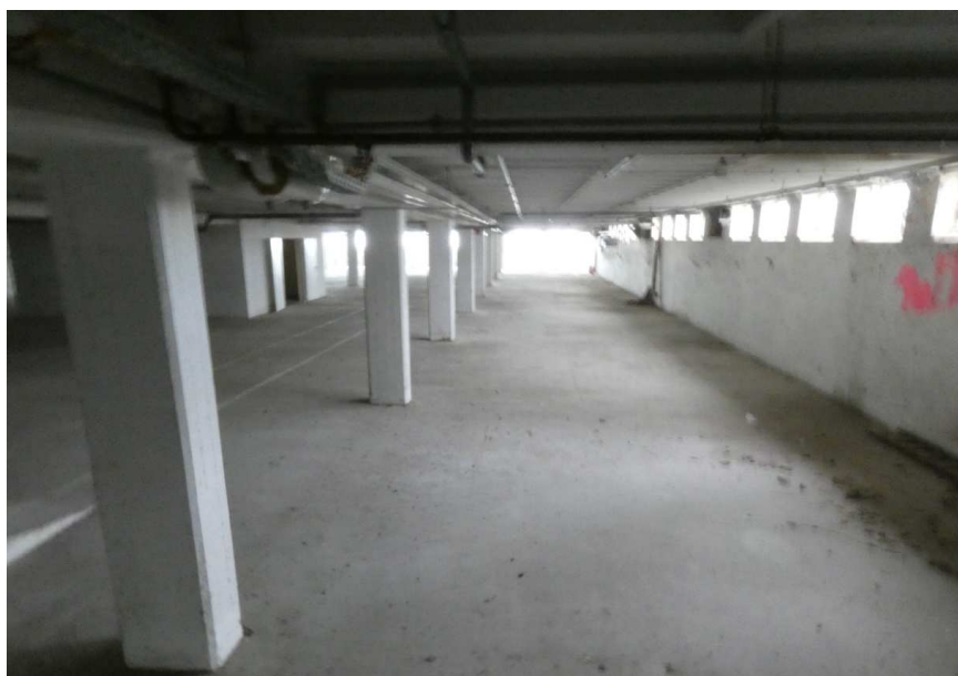
Abb. 24: Beispielbild Lichtverhältnisse Kellergeschoss (ohne künstliche Lichtquellen) (Quelle: H & P)
