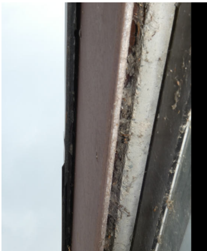
Abb. 14: Potenzielles Spaltenquartier entlang des Dachrandes Bürotrakt (Quelle: H & P)
