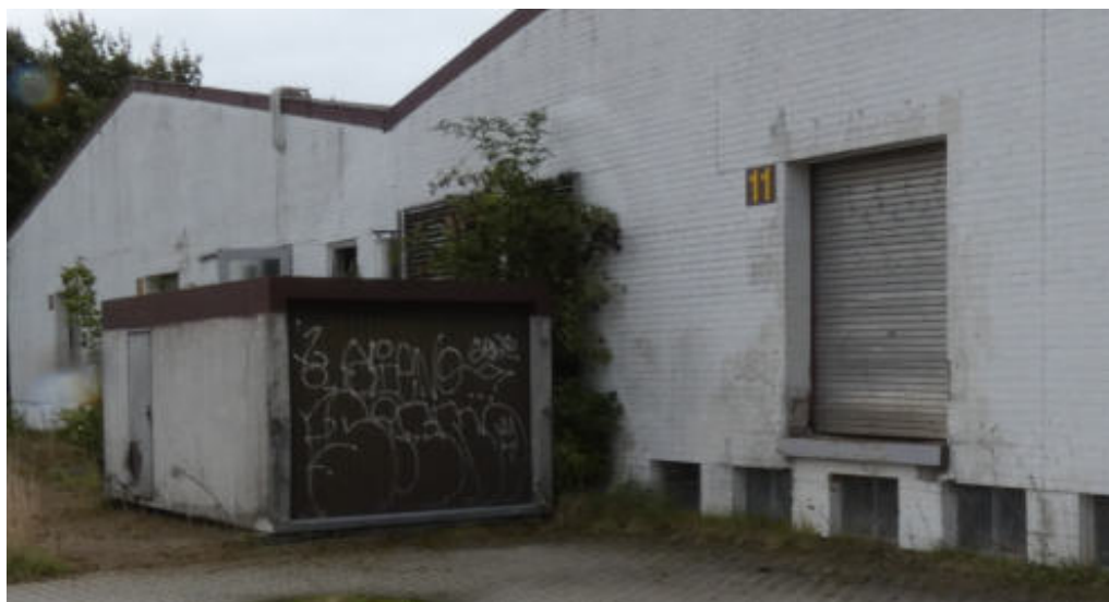
Abb. 10: Fertigteilgarage vor nordwestlicher Hallenschmalseite (Quelle: H & P)
