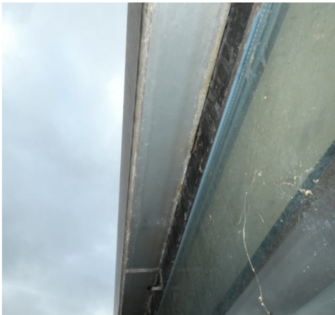
Abb. 13: Rollokasten an der Außenfassade Bürotrakt (beispielhafte Bildausschnitt, ohne Befund)
