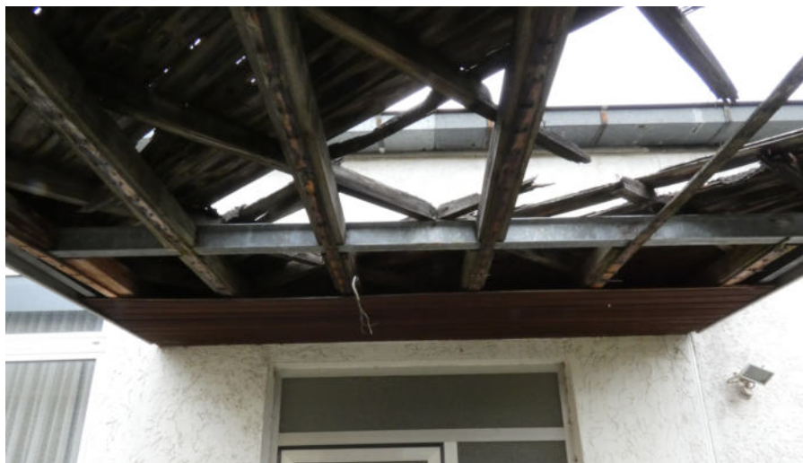
Abb. 17: Potenzielles Quartier im Bereich Dacheindeckung Personaleingang an der nördlichen Hallenlängsseite (Quelle: H & P)
