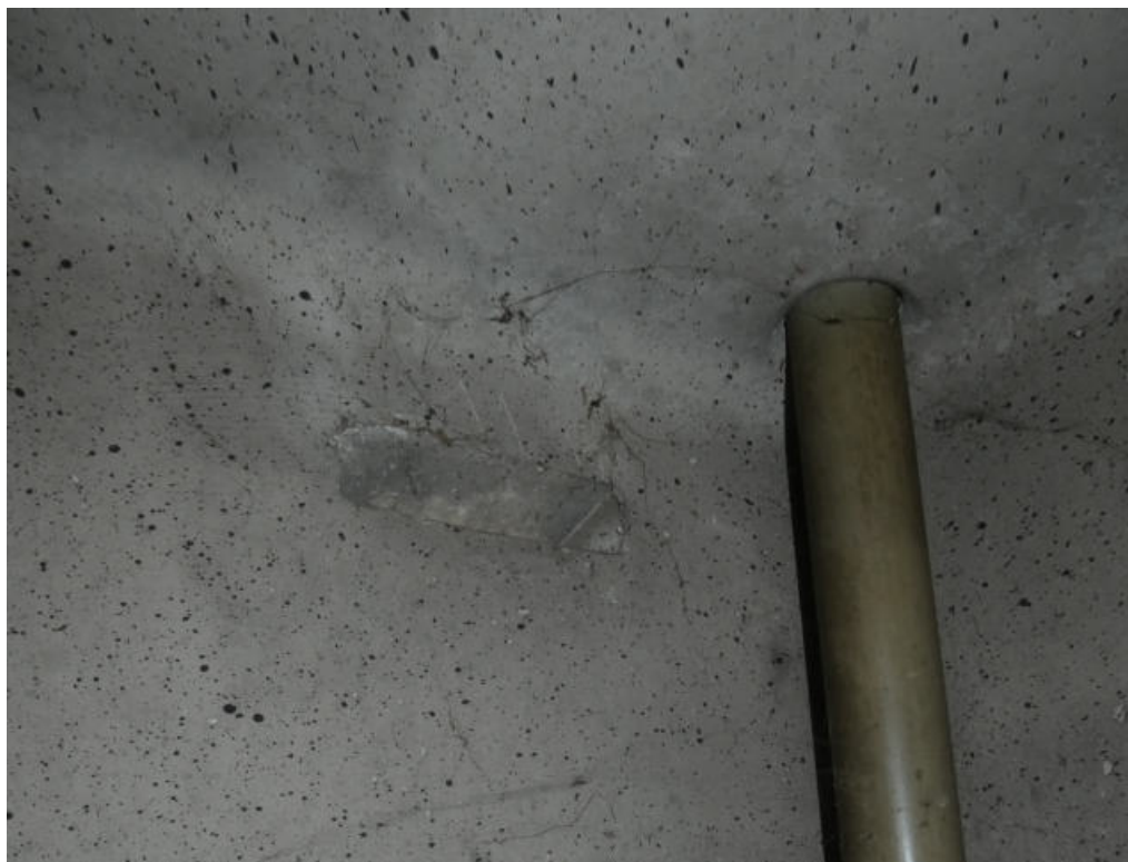
Abb. 11: Obere rechte Ecke Fertigteilgarage mit Lüftungsschlitz (Quelle: H & P)
