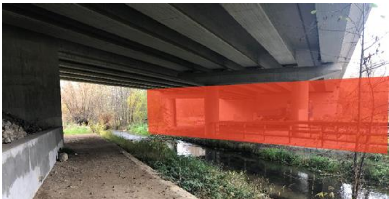
Abbildung 57: Beschränktes Raumprofil unter der Autobahnbrücke
