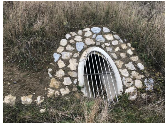
Abbildung 7: Dammdurchführung Autobahn
