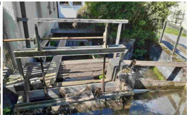
Abbildung 13: Schützenanlage (links) und Leerschuss (rechts) der ‚Fuchsenmühle‘
