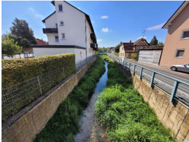
Abbildung 27: Ufermauern am Lauterbach
