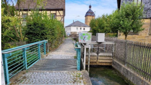
Abbildung 19: Streichwehr am Mühlbach (1)
