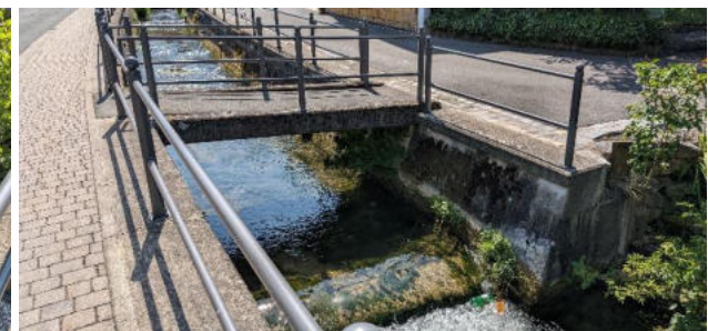
Abbildung 9: Steg und Sohlschwelle in Loffeld
