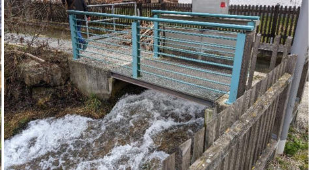
Abbildung 20: Streichwehr am Mühlbach (2)
