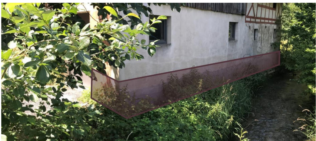
Abbildung 75: Mauerwerks-Abdichtung an der Außenwand des Anwesens ‚Fuchsenmühle 1‘
