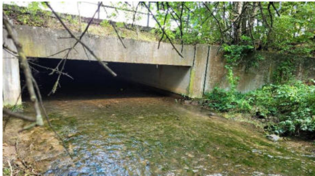
Abbildung 29: Rechteckdurchlass am Bahndamm
