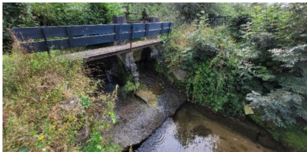
Abbildung 16: Ausleitungswehr für den Mühlbach (unterstrom der A73)
