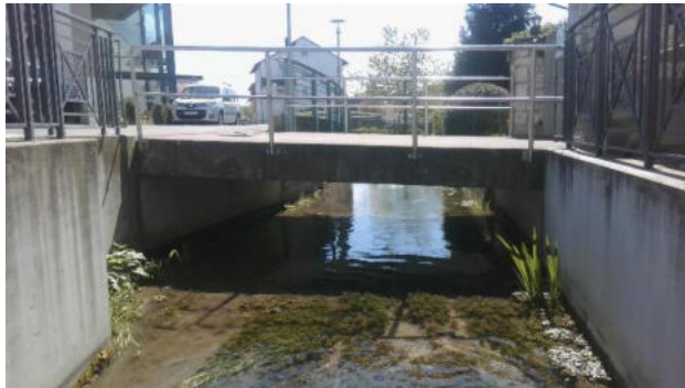
Abbildung 33: Fußgängersteg über den Mühlbach
