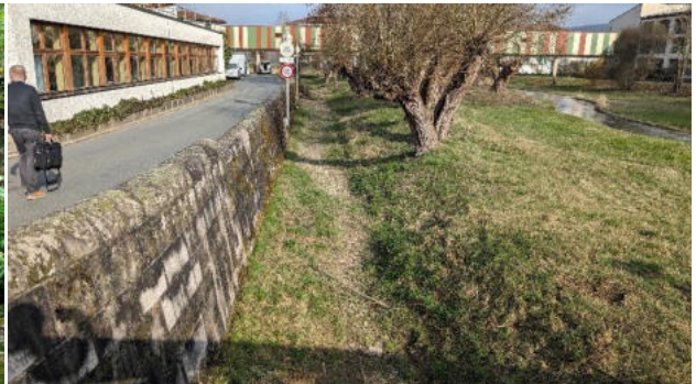
Abbildung 30: HWS-Mauer an der Obermain-Therme
