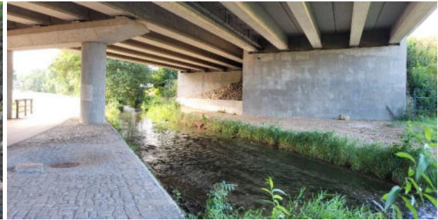
Abbildung 15: Uferbefestigung unterhalb der Autobahnbrücke
