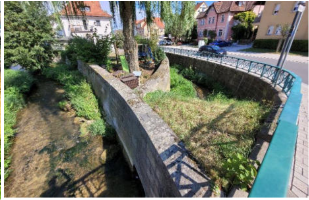
Abbildung 24: Überleitungsbauwerk ‚Goethestraße‘
