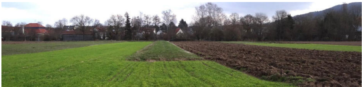
Abbildung 18: Bestehender Sommerdeich im linken Vorlandbereich des Lauterbachs
