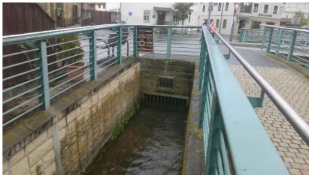
Abbildung 21: Auslauf des Mühlbachdükers
