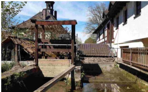
Abbildung 12: Einlaufbereich der ‚Alten Mühle‘
