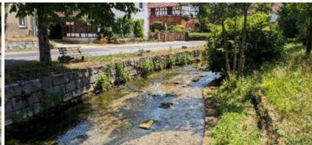
Abbildung 7: Ufermauer und Aufweitung in Horsdorf
