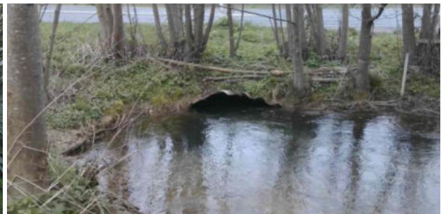
Abbildung 17: Verrohrung des Mühlbachs am ‚Äußeren Frankenring‘
