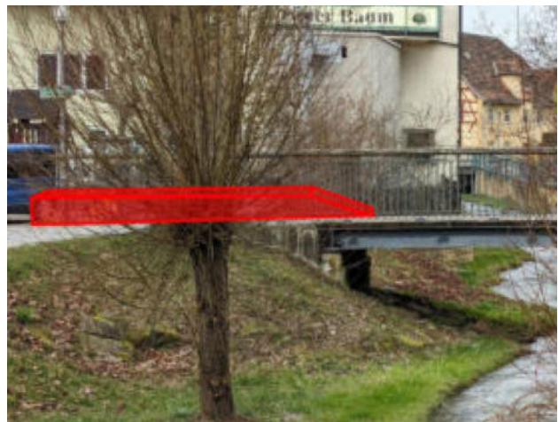
Abbildung 83: HWS-Mauer am Gasthof ,Grüner Baum‘ / Edeka-Parkplatz
