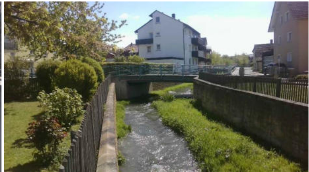
Abbildung 34: Straßenbrücke über den Lauterbach
