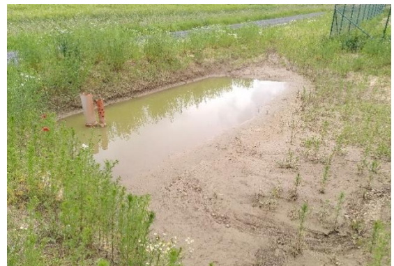
Abbildung 3: Beispiel eines nach Abbildung 2 erstellten Kleinrückhaltebeckens vor der Begrünung
