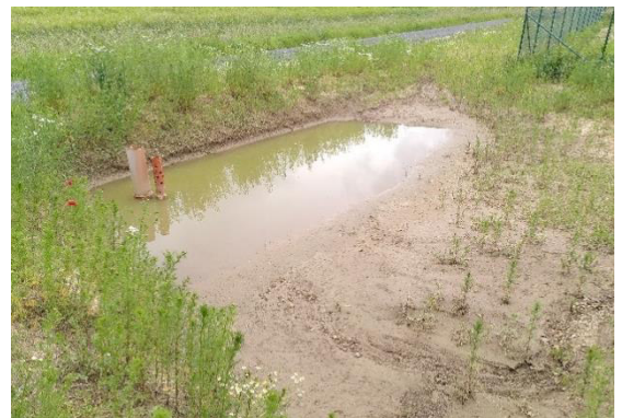
Abbildung 3: Beispiel eines nach Abbildung 2 erstellten Kleinstrückhaltebeckens vor der Begrünung
